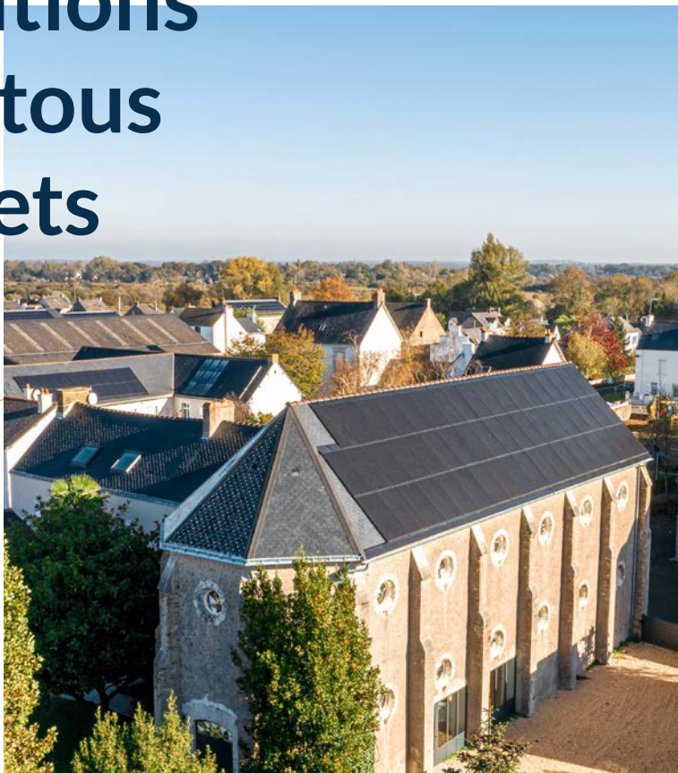
Rénovation d'une chapelle • Parc de Brière (44)
